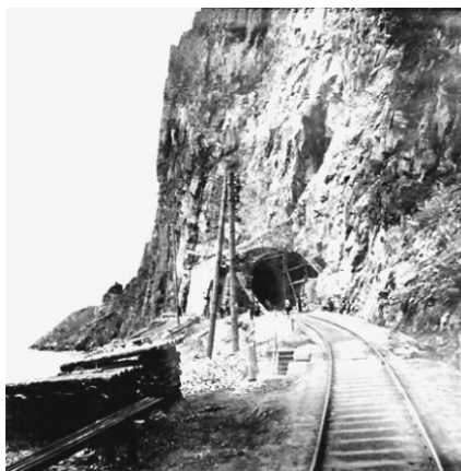
Строительство тоннеля на кругобайкальской железнодорожной линии, 1903 год
